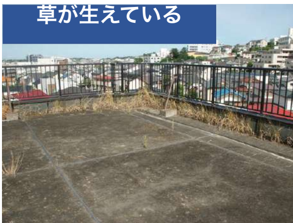
保護コンクリートの劣化
