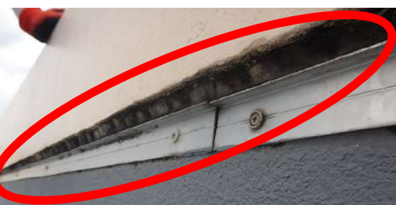
立上り部分のシーリングの劣化
